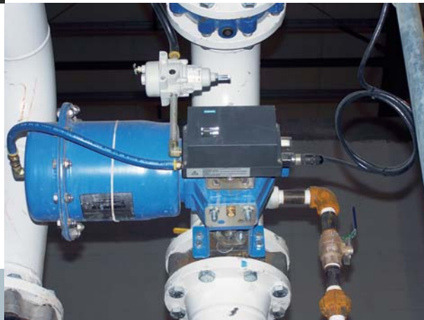
Control de válvulas con SIPART PS2 en una fermentación en régimen continuo
