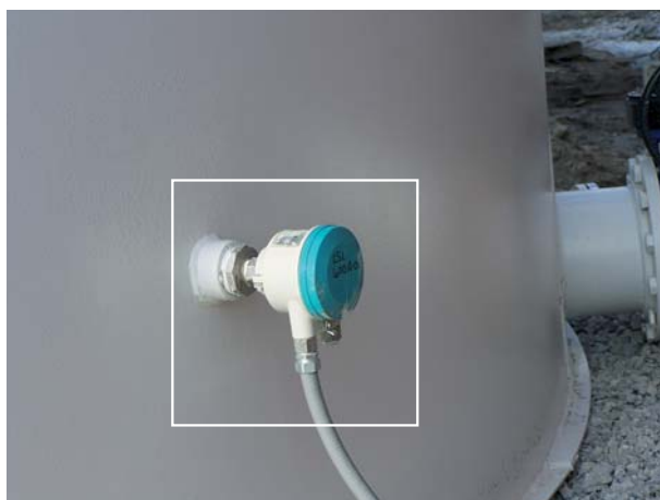
Monitoreo del nivel mínimo en un depósito de almacenaje con un detector POINTEK
