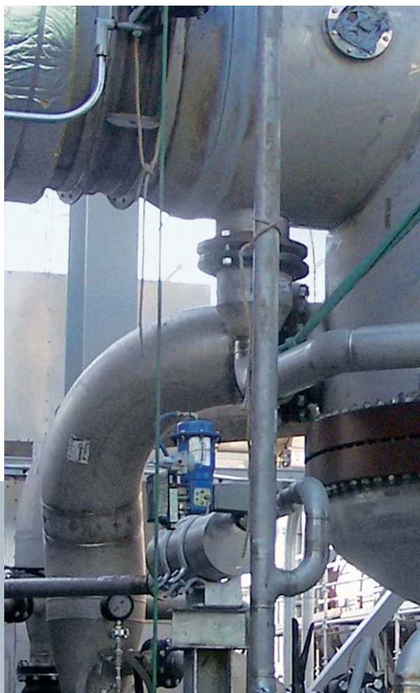
Medición de caudal basada en el principio de Coriolis en la unidad de secado
